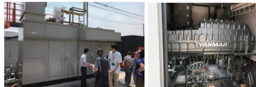
群馬県の株式会社アープさんの天ぷら油発電所を視察。廃棄される食用油を燃料に発電しながら熱も回収できる（コジェネディーゼルエンジン）。行政や市民団体など、ネットワークで回収ルートをつくっています。熱と合わせると変換効率は 80% を超え、この 1 基で約 300 世帯の電力を賄える規模！
