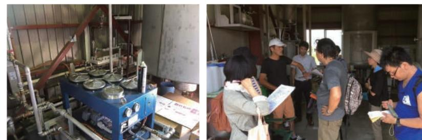
発電機は、ヤンマー製ディーゼル発電機 EP-160、出力は 145kWh。毎日約 1t の SVO を使用し、年間約 125 万 kWh (1.25TWh) の電力を生みだしています。これは、一般的な家庭約 400 軒分の電力使用量に匹敵します。発電機が発する騒音は、大型トラックのアイドリング程度といいます。そうした騒音が、気にならない立地が必要です。藤岡バイオマス発電所の立地としては、幹線道路沿い、裏手は水田、両脇は空き地。市街化調整区域の約 300 坪の敷地。
